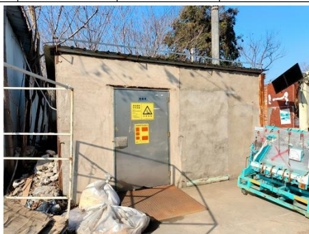
危废暂存间（外部）
