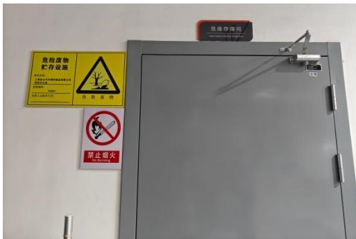
危废暂存间（外部）
