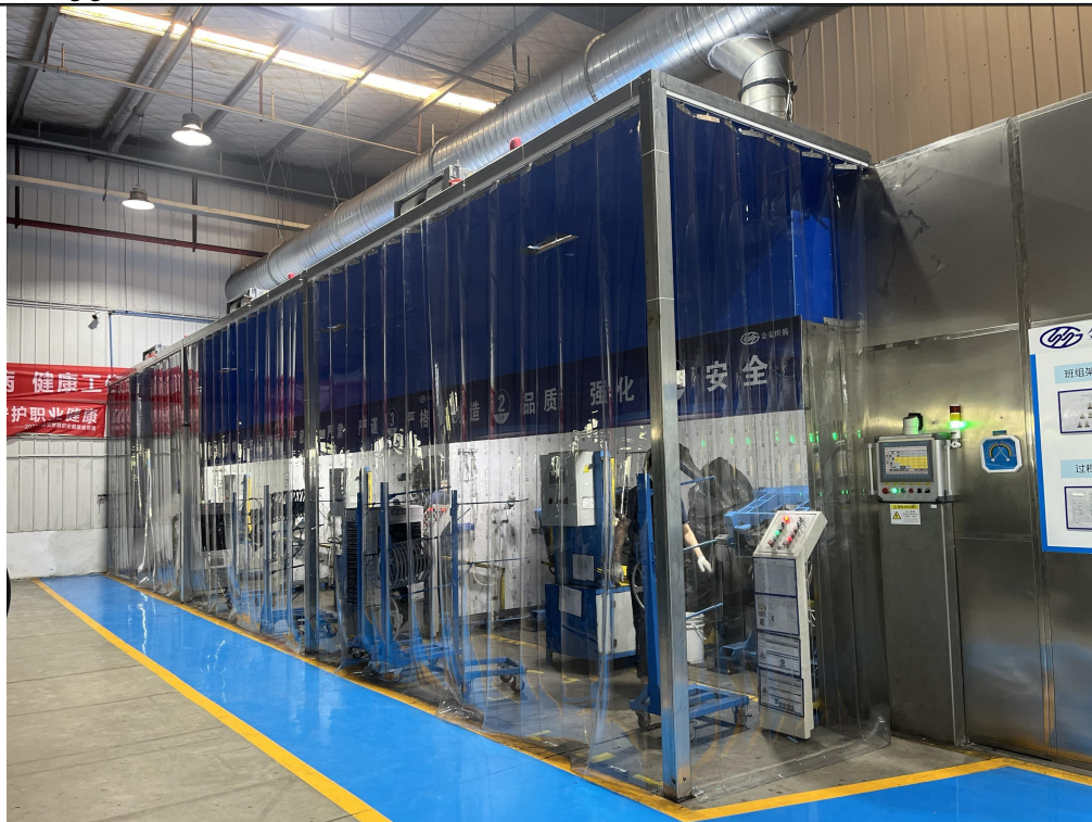
发泡工位集气罩+密闭隔间
